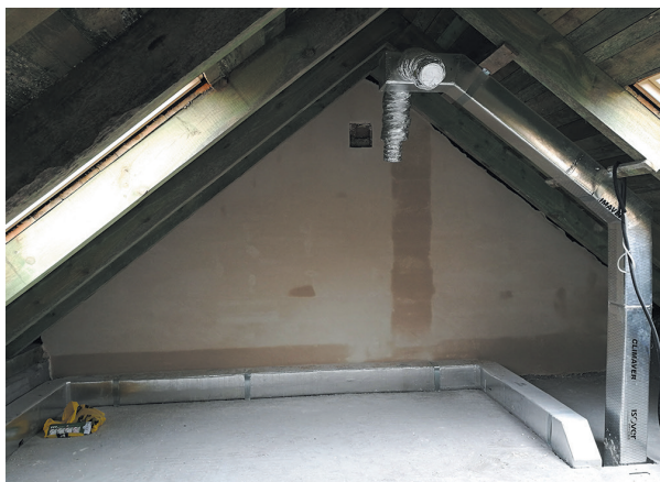
Instalacja rekuperacji na poddaszu
