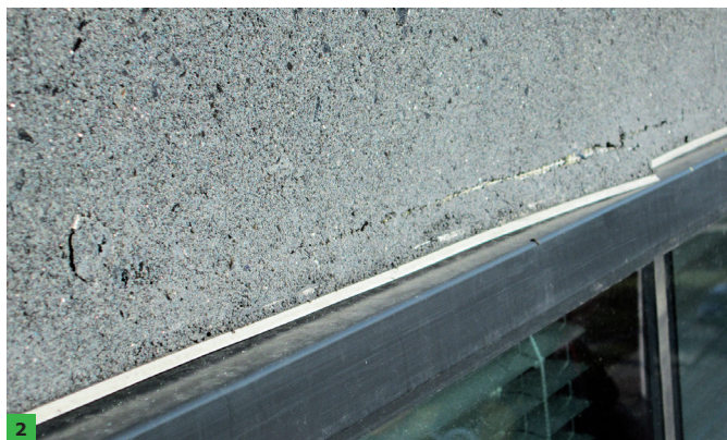
FOT. 1–2. Uszkodzenia elewacji spowodowane niewłaściwym wykonawstwem; fot.: SSO
