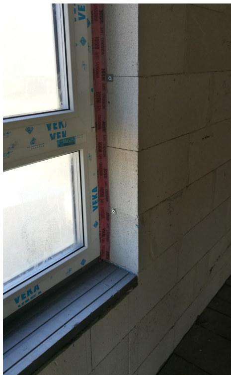
Odporownie zaprojektowana bryła budynku Stolarka powinna być prawidłowo zamontowana – szczelnie i bez mostków termicznych
