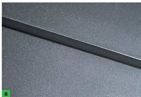
FOT. 5–8. Innowacyjne wyprawy zewnętrzne: efekt betonowej ściany wylewanej w szalunku (5), tynk dekoracyjny z dodatkiem płatków naturalnej miki (6), efekt drewna (deski) (7), efekt blachy (farby metaliczne) (8);
