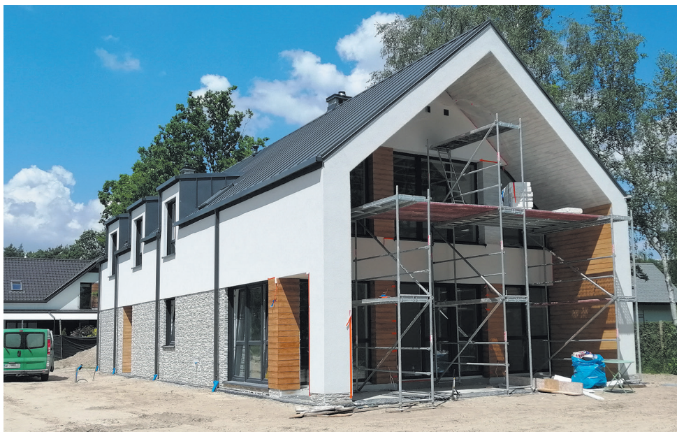
Odpowiednio zaprojektowana bryła budynku
