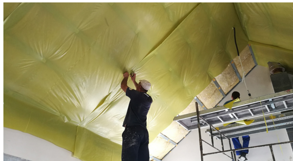
Więźba dachowa dobrze ocieplona i szczelna
