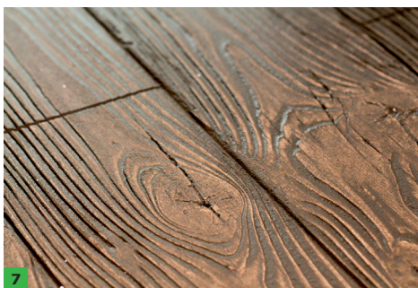
FOT. 5–8. Innowacyjne wyprawy zewnętrzne: efekt betonowej ściany wylewanej w szalunku (5), tynk dekoracyjny z dodatkiem płatków naturalnej miki (6), efekt drewna (deski) (7), efekt blachy (farby metaliczne) (8);
