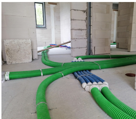
Budynek energooszczędny z instalacją rekuperacji i wentylacji mechanicznej
