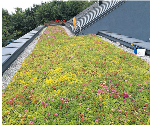
Dach zielony to bardzo dobre rozwiązanie w budynku niskoenergetycznym
